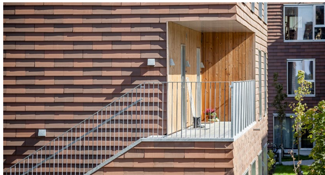
Nordre Fælled Kvarteret. Tilbagerykket altangang til til boliger. Foto: ONV arkitekter
