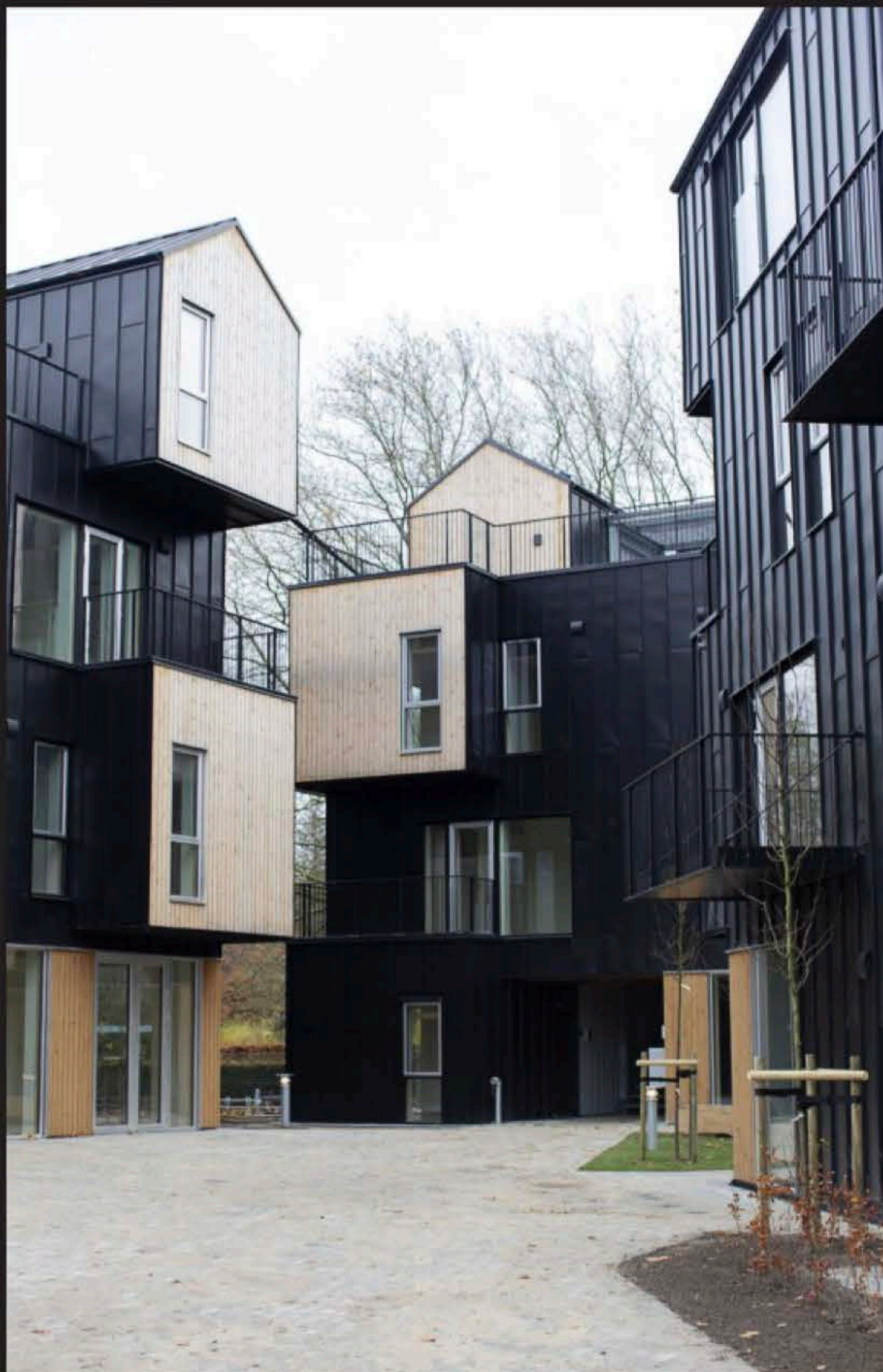
VENLIGBOLIGER. De unge studerende og flygtningene kommer til at bo småt og tæt. Overalt er der tænkt i, at man skal kunne have socialt samvær – kun på de små værelser kan man være alene. Delehuse er stablet af lejlighedsstore enheder bygget i træ. Foto: Mikkel Herlyck
